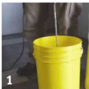
1 Prepare el adhesivo para fijar las placas
