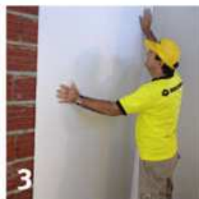
3 Pegue las placas a la pared o muro de aplome
